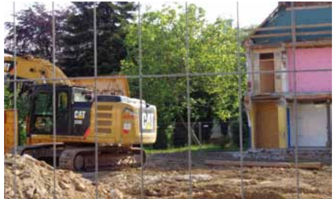
Im August beginnen die Bauarbeiten für den neuen Kindergarten, derzeit wird die Baufäche frei gemacht. Foto: privat
